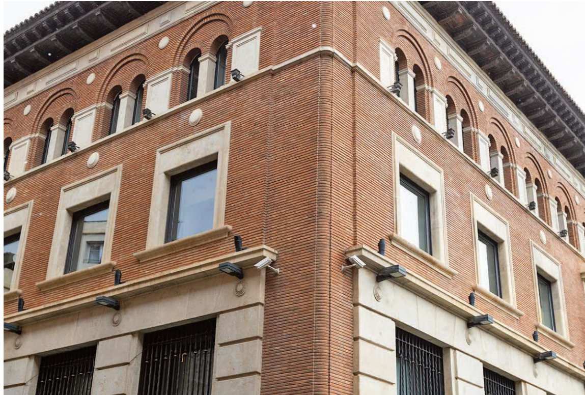
Sistema de alumbrado en el edificio del antiguo Banco de España, en la plaza San Juan. Javier Escriche
